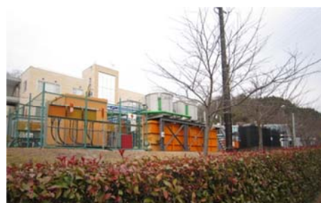
図6 排水処理設備
