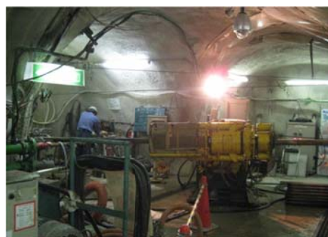
図7 水平ボーリング調査
