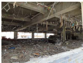
市庁舎1階の状況
