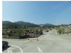
津波により壊滅状態の大田地区
