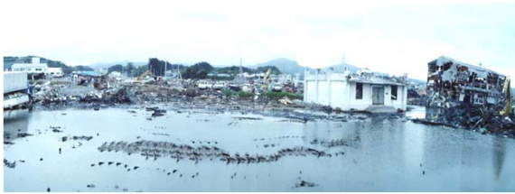
宮城県気仙沼市市川町 広域地盤沈下による水浸
