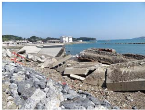
引き波で海側に倒壊した防潮堤
