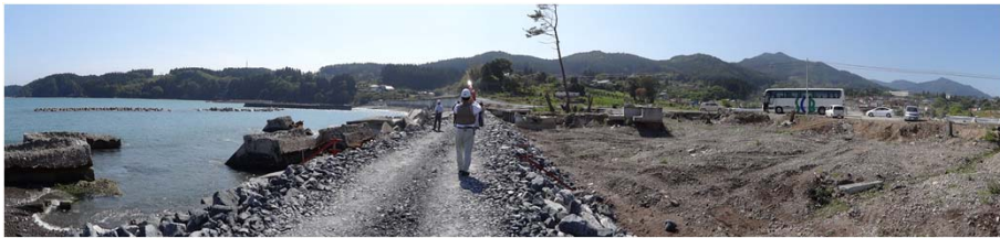
岩手県大船渡市大田地区(門之浜湾の防潮堤の破壊)
