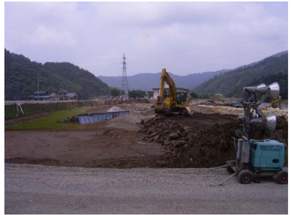
写真－4 堤内地側まで流されていた橋桁
