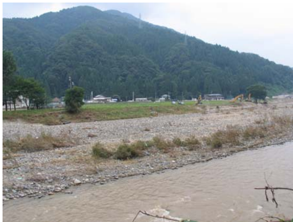
写真-11 美山町朝谷島の堤防被害
