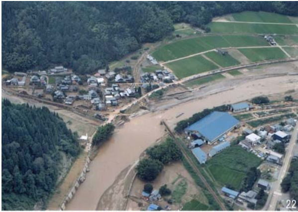
写真－1 被災堤防の航空写真（福井県提供）
