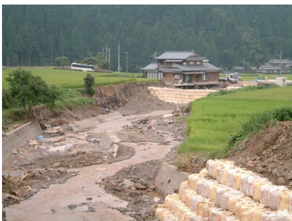
写真－8 浄教寺町での被害 1
