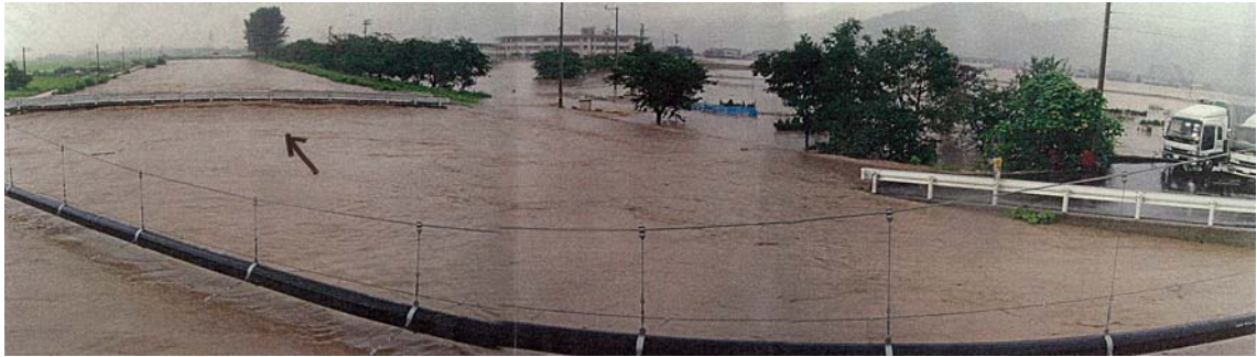
写真－15 鯖江市川島町での鞍谷川右岸堤防での越水（福井県提供）
