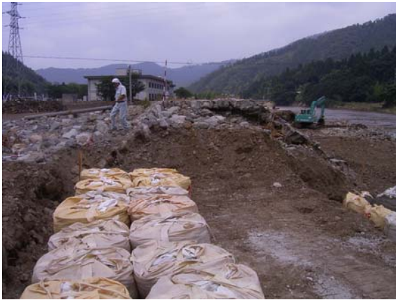
写真－3 被災堤防の断面
