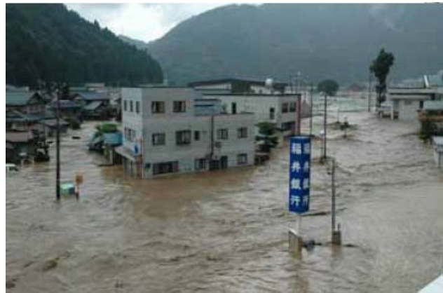
写真-10 美山町役場付近の被害 1)
