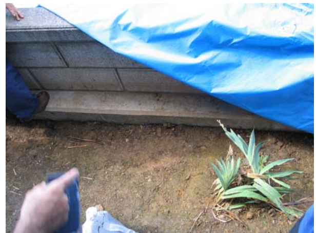
写真－18 擁壁護岸の背面の状況
