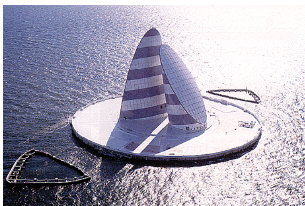
現在の川崎人工島（風の塔）：海底トンネルの排気口となっている （建設時にはシールドの発進基地として使用）
