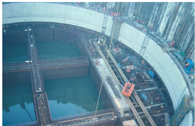
注水により水位が落ち着いた状況
