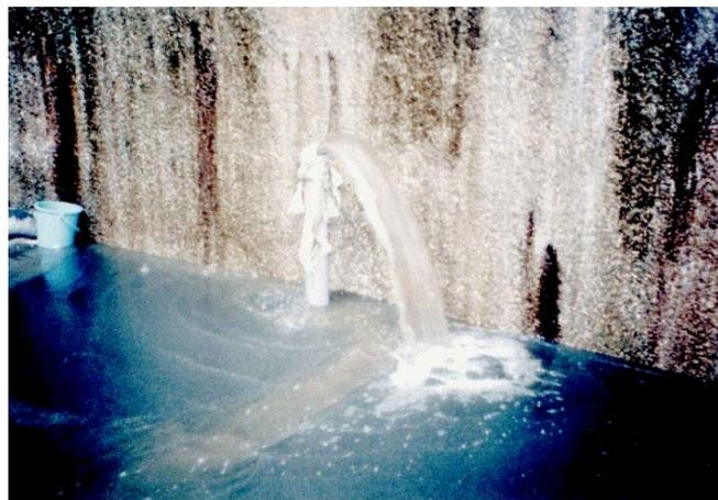
↑ 出水当初の状況 厚さ 50cm のコンクリート盤の下に通した水抜きパイプから 2,000t/日の湧水
