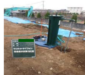
写真 2 現場透水試験の様子
