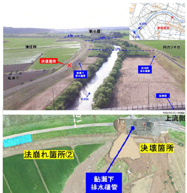
図1 石沢川左岸1.0kの決壊箇所(報告書 1) より引用加工)
