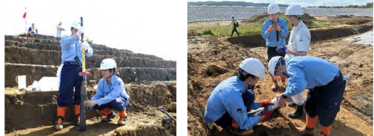
図5 上流側開削断面で実施した二重管サンプラーによる試料採取
