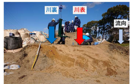
写真1. 現場開削調査
