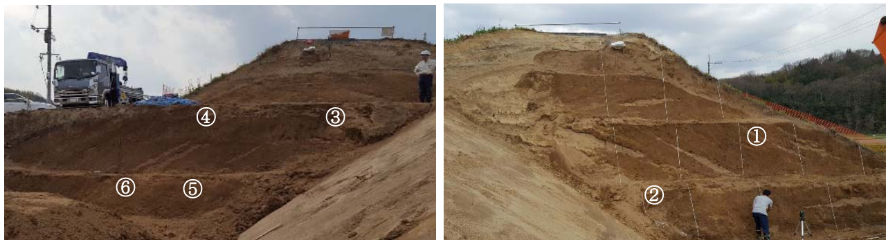
図3 右岸 0.6k の法すべり箇所における開削調査時の現場透水試験の実施箇所（左図：上流断面，右図：下流断面）
