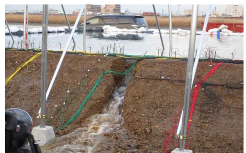
写真 3 切削による越流の様子
