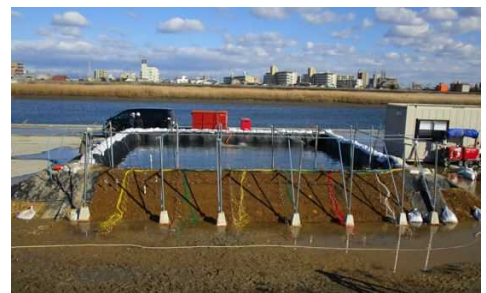
写真 1 堤体模型全体の様子
