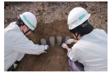
写真2 現場の簡易サンプリング
