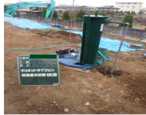
写真1 現場透水試験の様子
