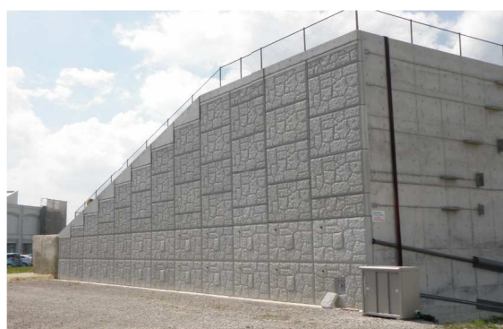
写真 1 補強土壁の全景
