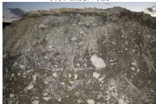
写真7 堤防開削面
