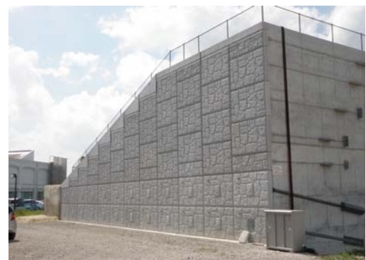
写真 1 補強土壁の全景
