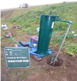
写真2 現場透水試験の様子
