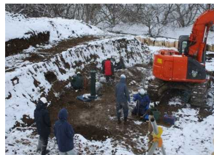
写真-2 ニッ森川での調査状況
