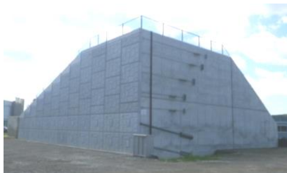
写真1 補強土壁の全景
