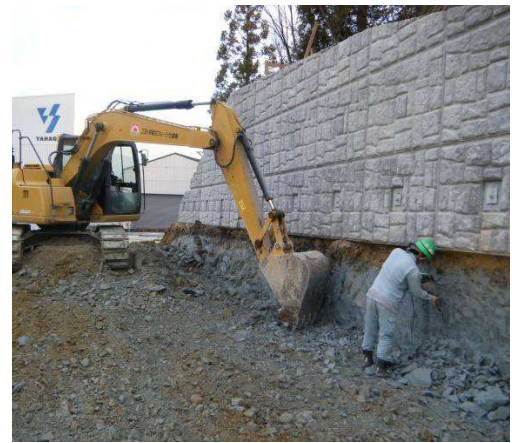
写真-1 4段目の掘削状況
