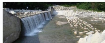
耐摩耗性材料の実河川落差工における現場耐久試験
